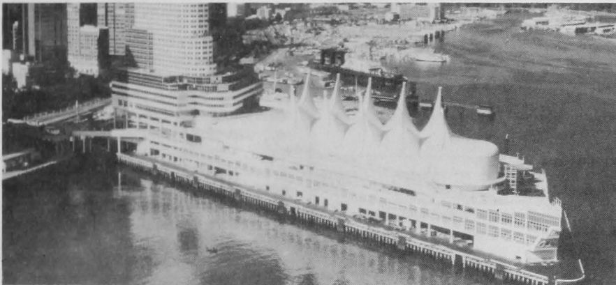
A Vancouver, une période de soleil et de sécheresse, d'une durée record de 53 jours, a fait monter le nombre des visiteurs d'Expo 86 (photo du pavillon du Canada: MEIR).
