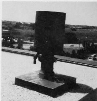
*La base du radôme contient un des objets les plus étranges du toit: un contenant brun disgracieux qui évoque la tasse dans laquelle aurait bu un dinosaure. C'est un dispositif d'évacuation de rechange pour la chaufferie.*
