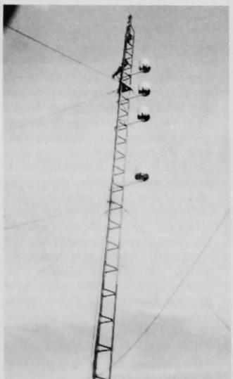
Sur le côté nord, observez la construction la plus haute du toit, une tour de 25 mètres dont se sert actuellement la Direction de l'acquisition des données pour une expérience internationale de détection solaire. Quatre capteurs solaires flanquent la tour qui sert aussi de paratonnerre et d'antenne d'essai pour les signaux de la haute atmosphère provenant du radôme voisin.
