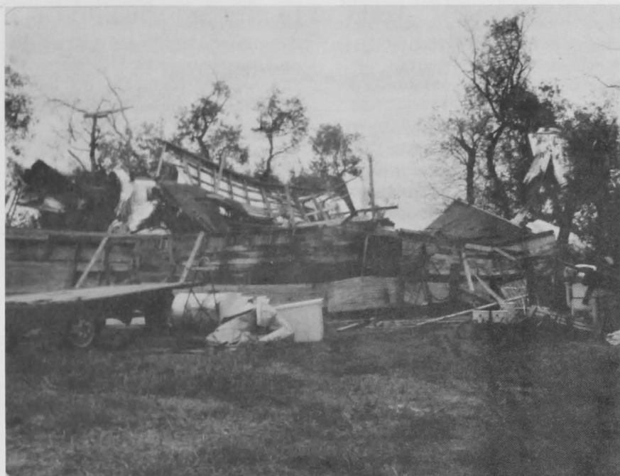
Une tornade a gravement endommagé cette ferme de Yorkton (Saskatchewan).
