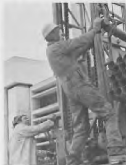
Conduites déchargées d'un derrick par des travailleurs d'une société privée de forage avant d'être noyées au fond d'une nappe aquifère sous le terrain de stationnement du bâtiment du SEA, à Downsview.
