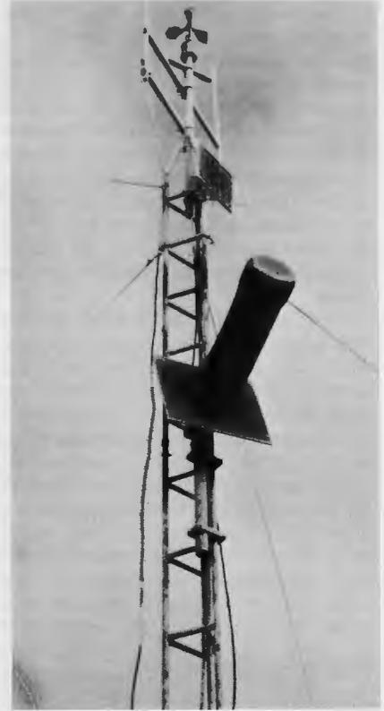
La tour de la station météorologique automatique MAPS<sup>R</sup> contient deux pièces d'équipement non traditionnelles: une antenne cylindrique pour la diffusion des données à un satellite géostationnaire et, au-dessus, une plaque carrée comportant les nombreuses cellules circulaires d'énergie solaire qui fournissent l'électricité à la station.
