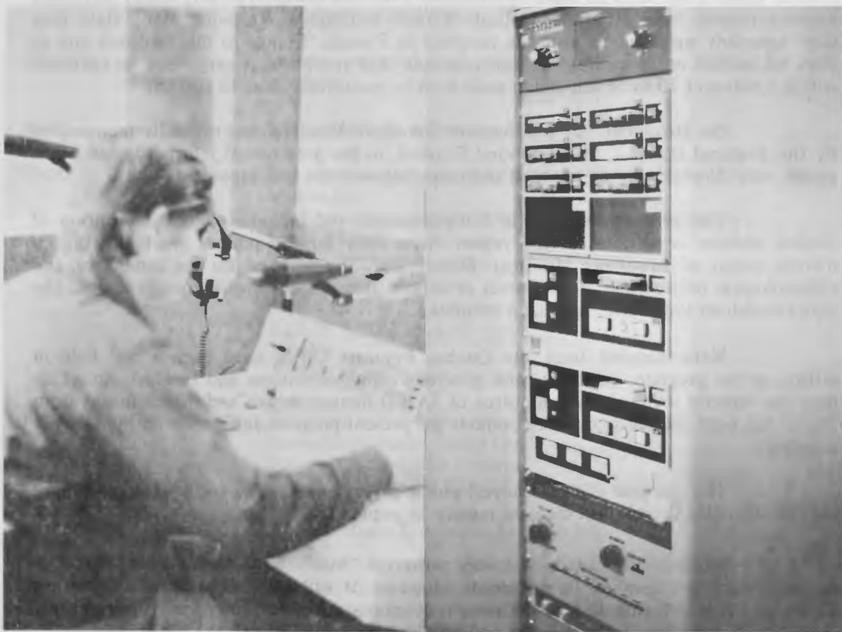
The recording console provides remote control of the tape recorders in a soundproof studio. Une console d'enregistrement permet le contrôle à distance des magnétophones à l'intérieur d'un studio insonorisé.
