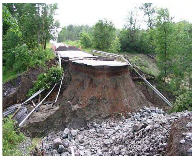
Route "Chemin des Érables" emportée par la crue soudaine du ruisseau. Photo de Dominic Gagné, Gatineau, QC, juin 2011.
